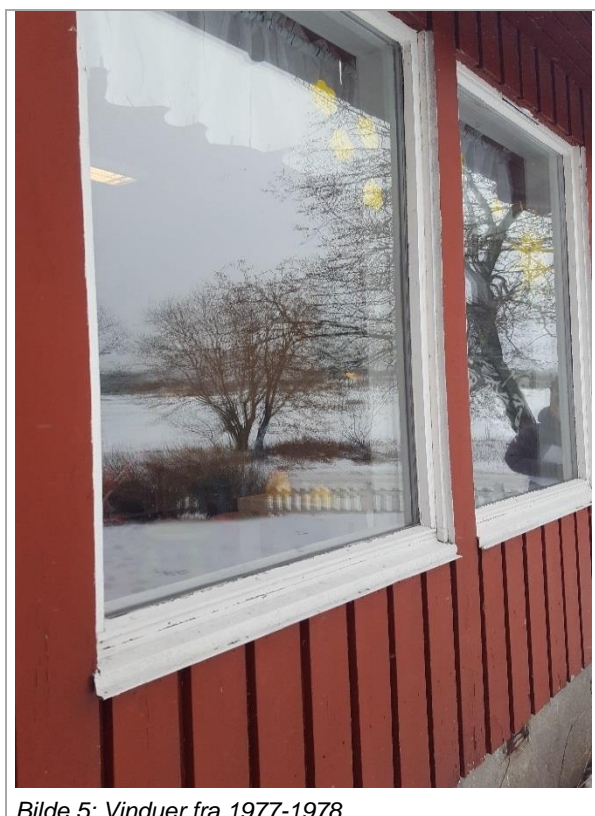
Bilde 5: Vinduer fra 1977-1978
