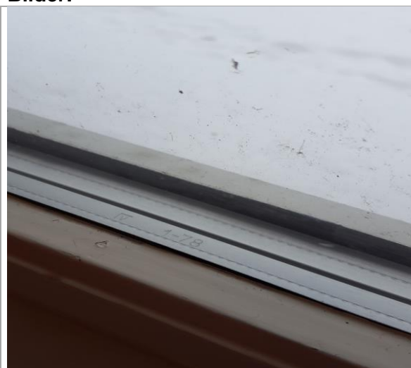
Bilde 1: Vindu fra 1978.
