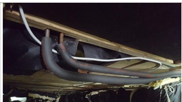
Bilde 8: Kobberrør med cellegummi som isolasjon.
