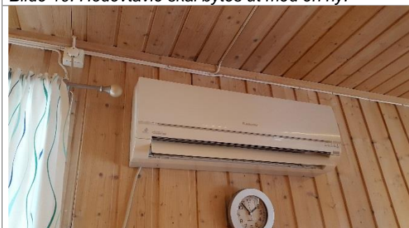
Bilde 12: Varmepumpe.
