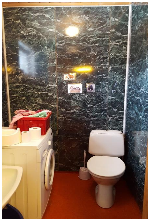
Bilde 4: Baderomsplater i storbarnsavdeling, ikke prøvetatt. Antas å inneholde ftalater over grensen for farlig avfall pga. alder.
