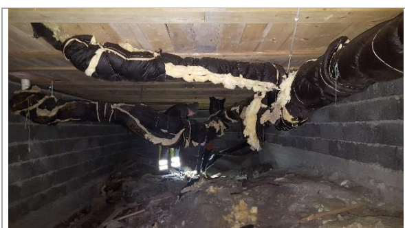
Bilde 16: mineralull som rørisolasjon.
