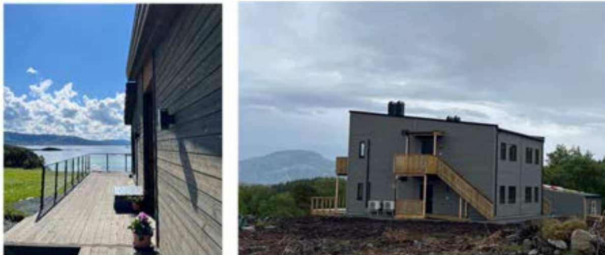
Boågen til det private paret om er bygget av Trekon AS omfattet mange gode arkitektoniske løsninger (til venstre). Firemannsboligen som Leka kommune har engasjert Mesterhus AS for å realisere på Klokkargården (til høyre)
